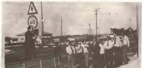
Ariba 4 di October ultimo diputado di D.O.W., Sr. Roland Lacle a inaugura e ultimo fase di reconstruccion di e carretera Oranjestad - Santa Cruz. E ceremonia cortico a tuma lugar na e cruzada di Dadelstraat y e carretera pa Meiveld.
